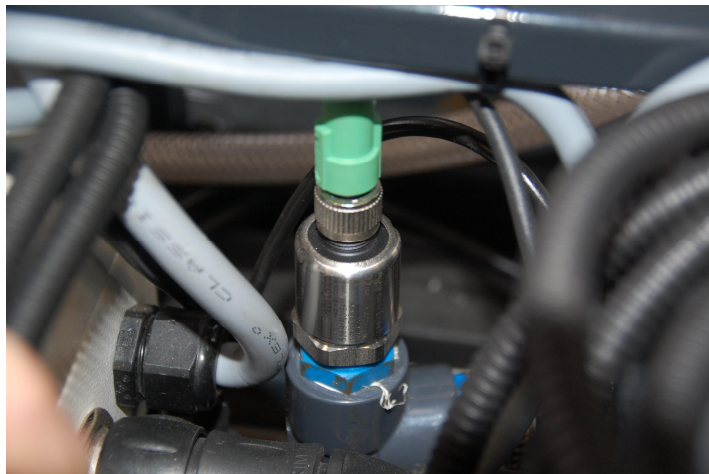
Figur 24, Aflastningsventil, manometer og pumpejustering
