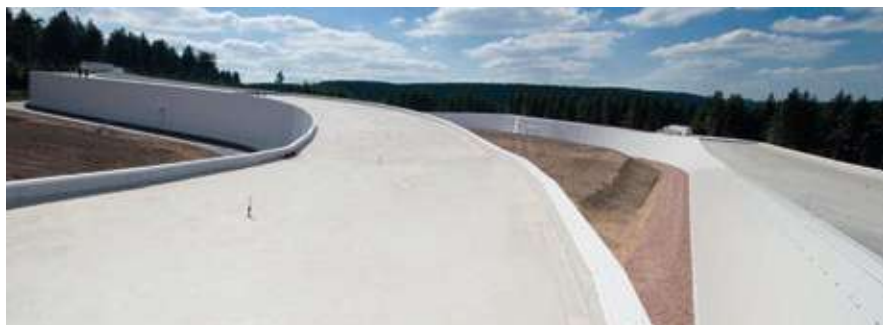
Differenzierte Gebäudeformen mit ROMA Schnellbau-Dämmpaneele (Skihalle Oberhof)
