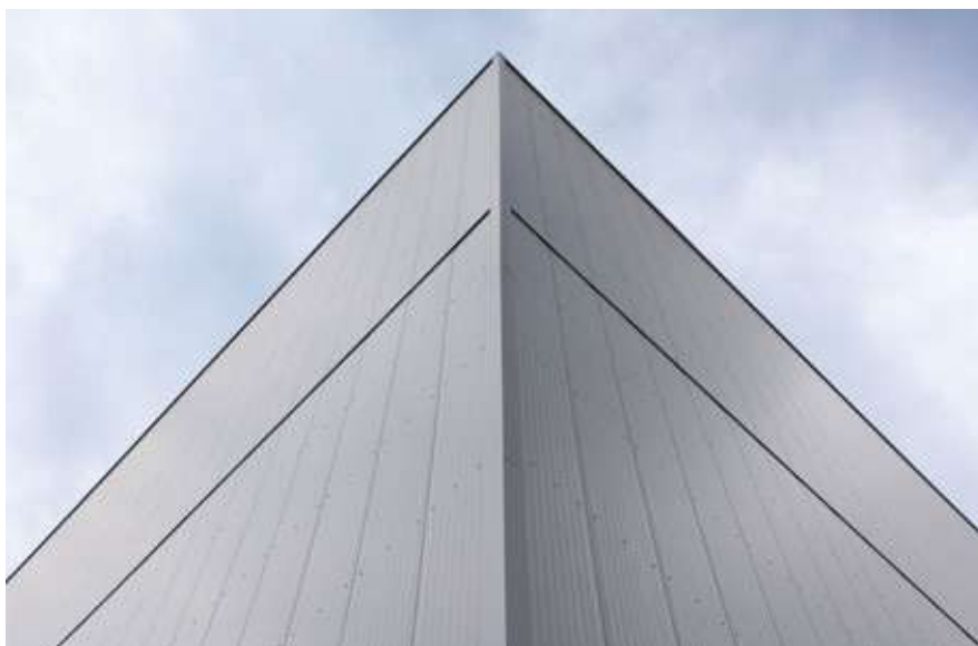
Hochregallager mit vertikaler Verlegung.
